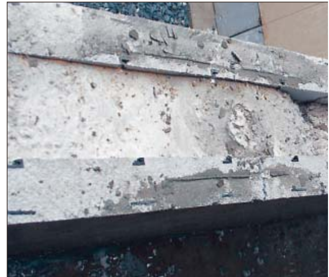
FERDIG FYLLT FORM: Med neopor på begge sider av betong trent høy. Blokkene har ferdige spikerslag og kan eventuelt pusses. Mulighetene er mange.
